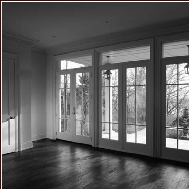
Restauratie Villa Aerdenhout
